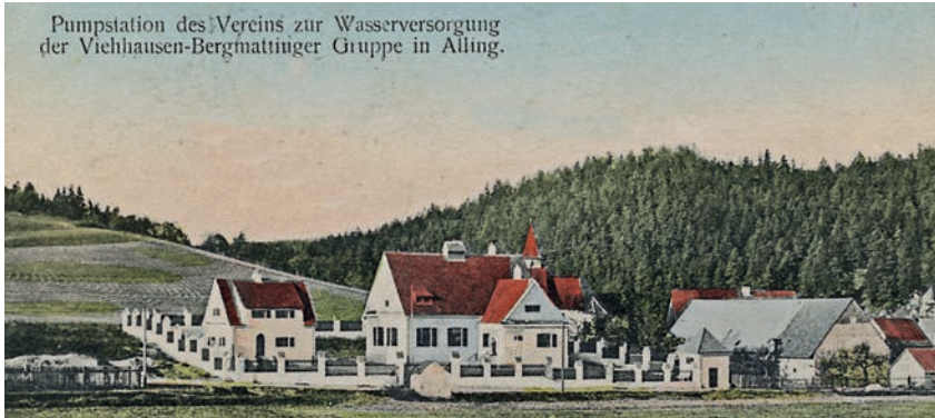
Pumpstation des Zweckverbands zur Wasserversorgung der Viehhausen-Bergmattinger Gruppe in Alling, Postkarte um 1911
