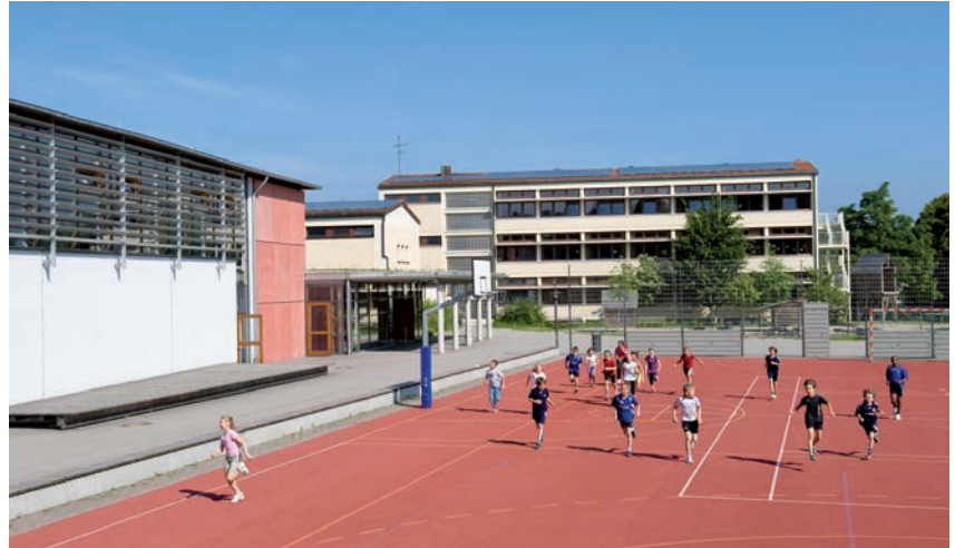
Schule Sinzing (erbaut 1959/60) mit Sporthalle und Sportplatz
