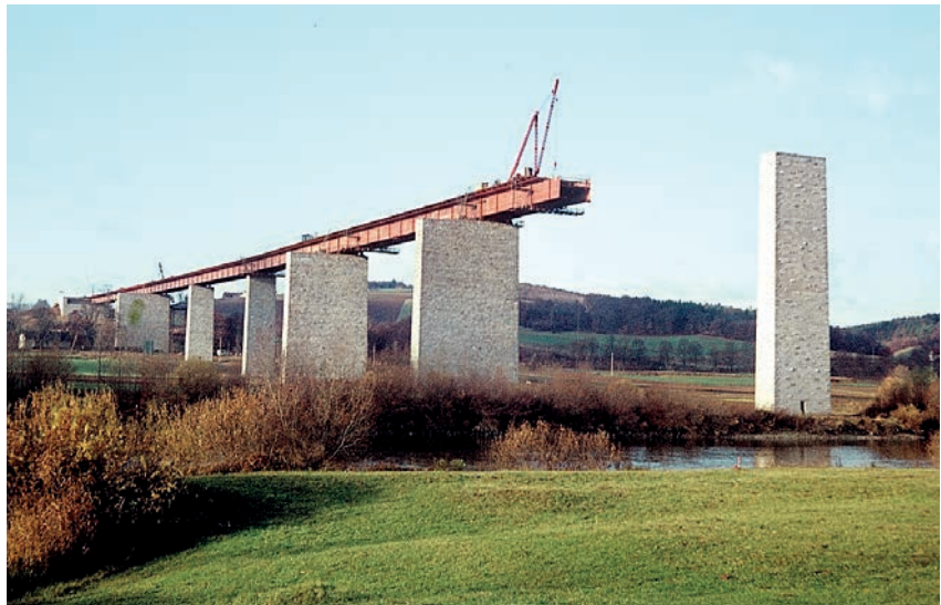
Bau der Autobahnbrücke im Oktober 1963
